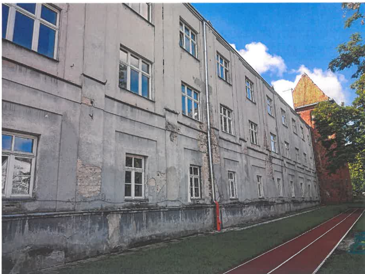
Elewacja tylna ( północno – zachodnia )
